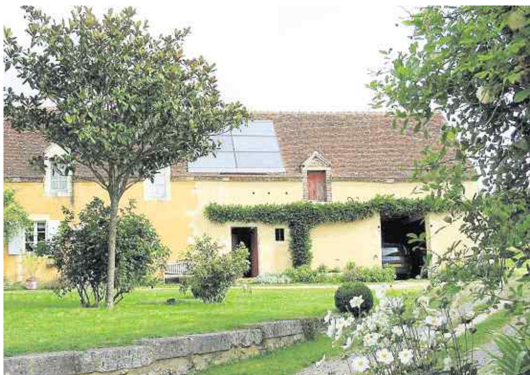
Un bel exemple d'intégration de panneaux solaires sur une toiture ancienne.
